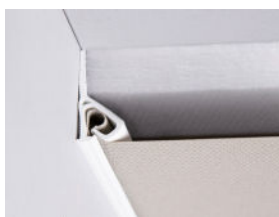
Clipso loftmontage med PCW profiler.
